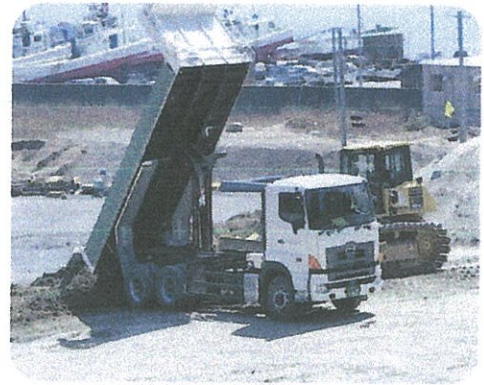
(進む盛土工事)
